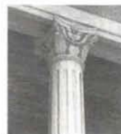
2階ベランダ柱頭飾り
