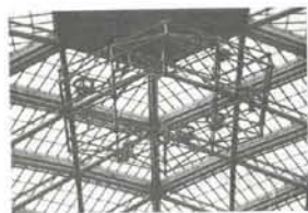
▲写真の三角形が単層ラチス構造
