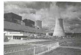
▲火力発電所。タワーが見える
