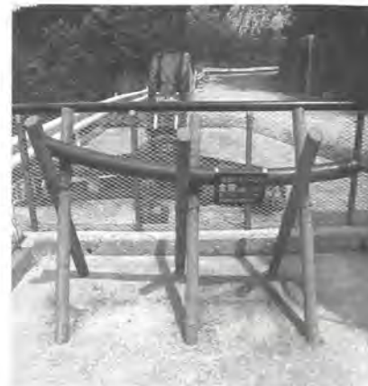
ケーブルクレーン
