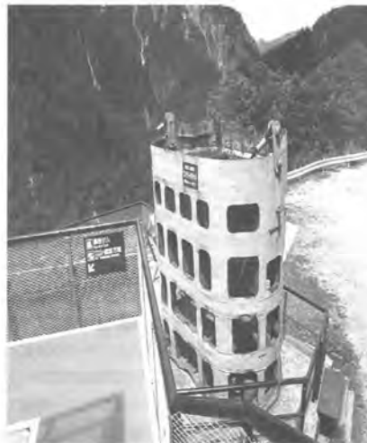
コンクリートバケット
