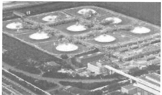
写真-3 東扇島 LNG タンク（9 基）
