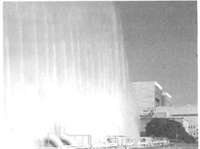
写真－5 水幕遮断装置
