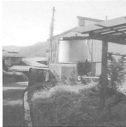
（写真－6） 民宿の井戸水タンク
