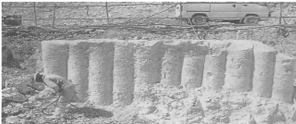
図-6 地下ダムの現場 3
