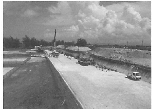
図-2 地下ダムの現場 1
