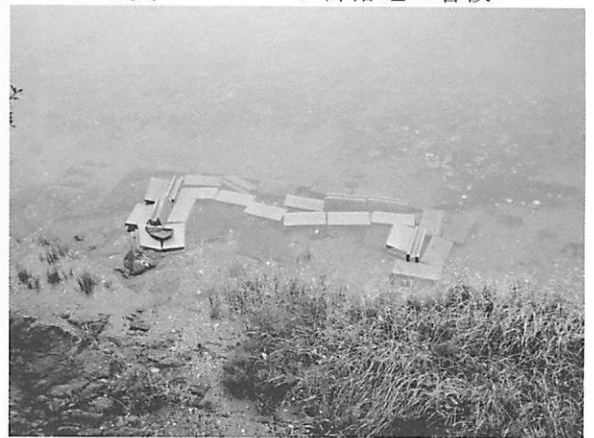
写真-5 防波ブロック
