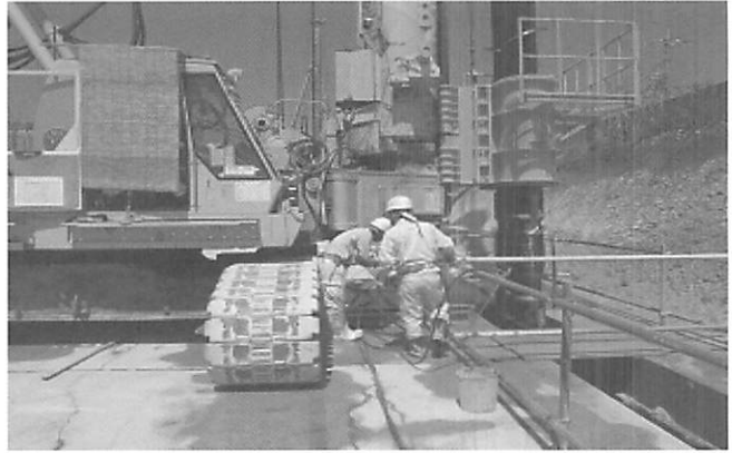
図-4 地下ダムの現場 2
