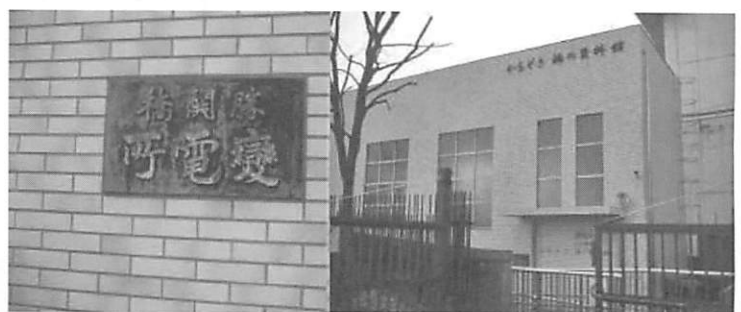
図-13 資料館の概観と変電所のなごり
