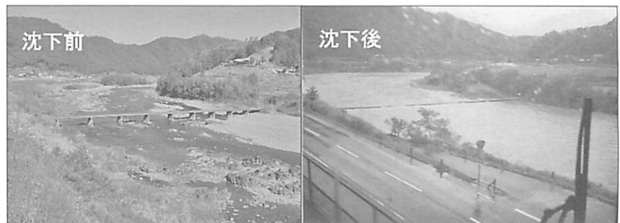
図-2 沈下橋の沈下前 2) と沈下後の四万十川
