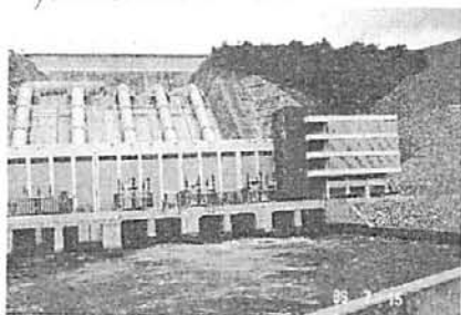
ダムの導水管と発電所 導水管4本が発電用でのこりの1つが揚水用。 ここでカンチャナブリ地区への送電など全てを管理している。
