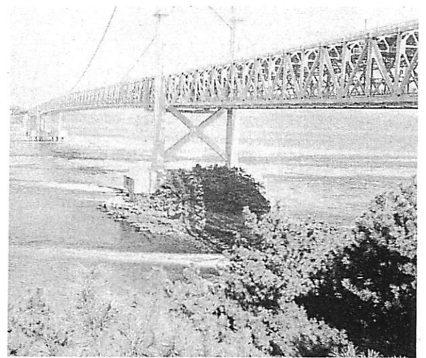
鳴門海峡、大鳴門橋を、鳴門公園展望台より望む。向う側が、兵庫県は淡路島、この位置からだと、海流の速さがよくわかる。
