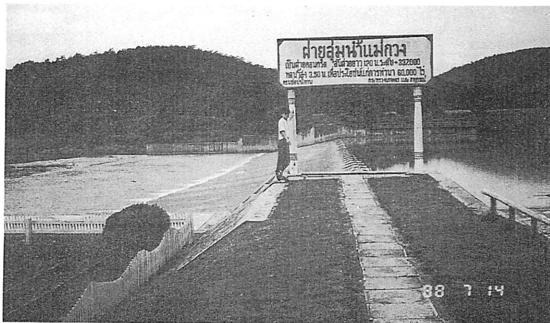
〈メクワンプロジェクトエリアの配水堰〉 (堰の周囲は緑地公園となっており、憩いの場となっている。)
